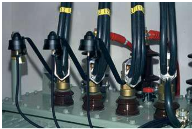
LVA-440B-DL chrániaci distribučný transformátor
