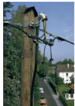
LVA -280B-FS chrániaci prechod vonkajšieho vedenia do kábla
