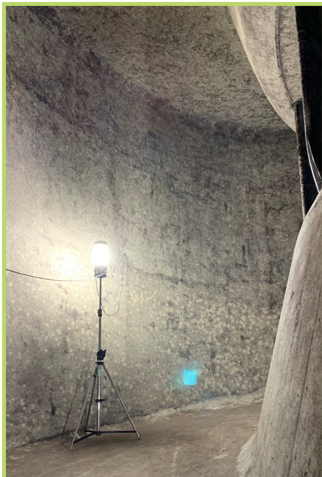
ApolloLED ECO – Osvetlenie počas revíznych prác v elektrárni
