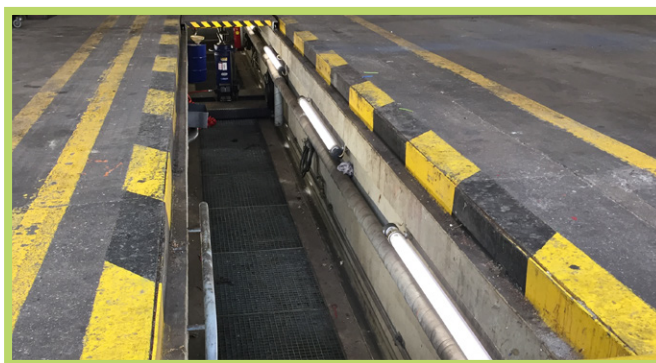
StreamLED Power – Osvetlenie montážnej jamy
